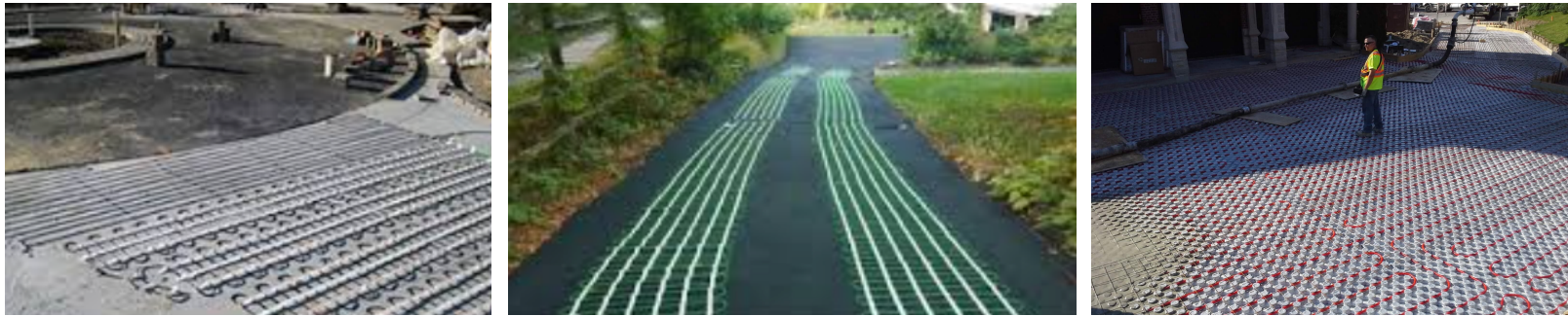
Exemples de trottoirs et chaussées chauffantes (crédit : Google Image)
